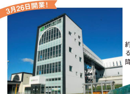
約25mの高さがある ガラス張りの昇 降棟が目を引く
